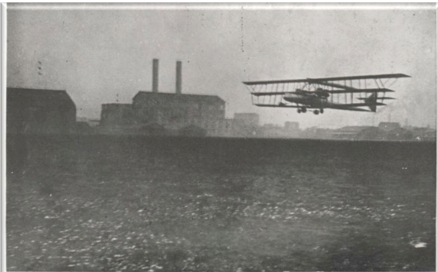
Deuxième modèle de triplan 4 moteurs Hispano de 220 CV démultipliés. Issy, 1916.
